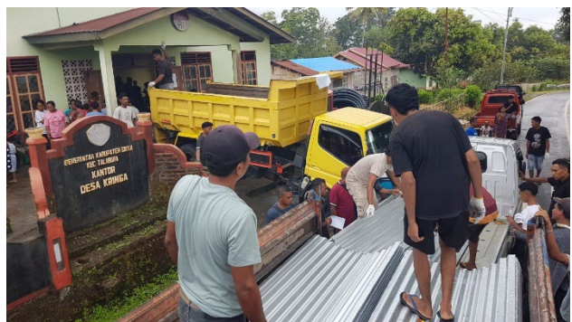
Dakreparaties bij vorige uitbarstingen.
